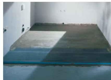
Izolacyjna płyta budowlana (fot. Wedi) na podłożu betonowym
