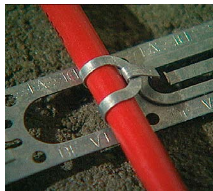
Kabel grzejny przymocowany do taśmy DEVIfast™
