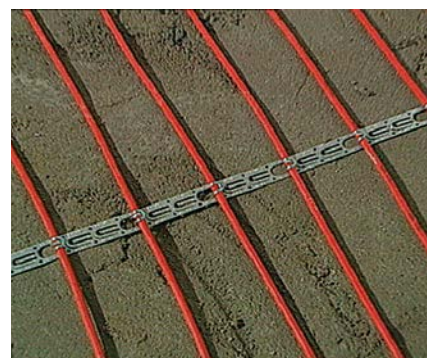
Kabel grzejny przymocowany do taśmy DEVIfast™
