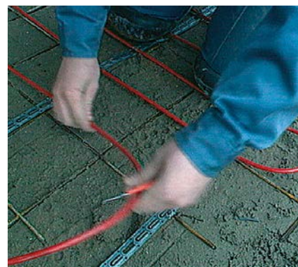
Montaż kabla grzejnego
