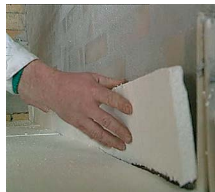
Montaż izolacji pionowej
