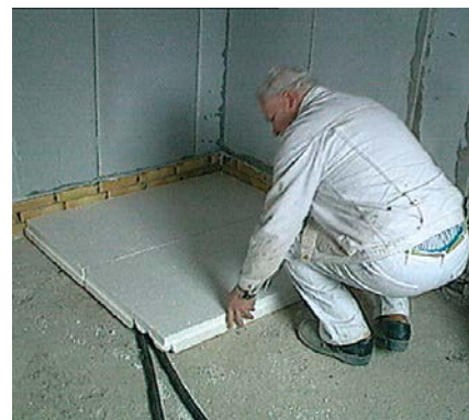
Montaż izolacji
