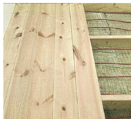
Montaż ogrzewania podłogi drewnianej na legarach
