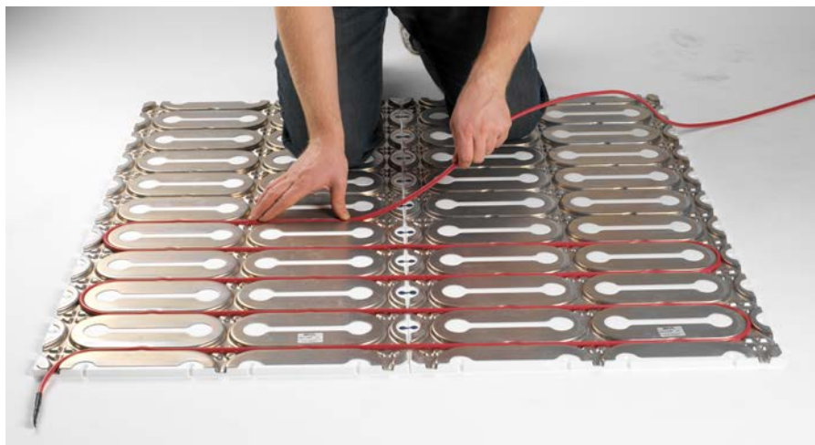
Sposób montażu kabla grzejnego z użyciem płyty DEVlcell Dry™
