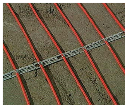
Kabel grzejny przymocowany do taśmy DEVIfast™
