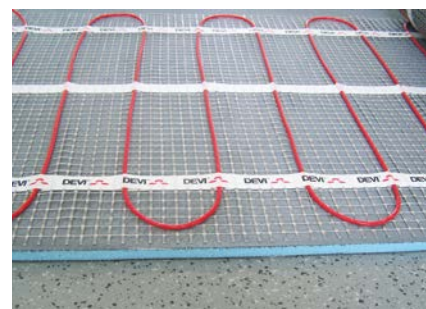
Izolacyjna płyta budowlana (fot. Wedi) z rozłożoną matą grzejną DEVIheat™
