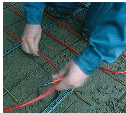
Montaż kabla grzejnego
