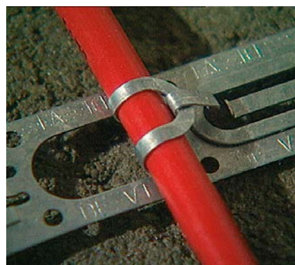
Kabel grzejny przymocowany do taśmy DEVIfast™
