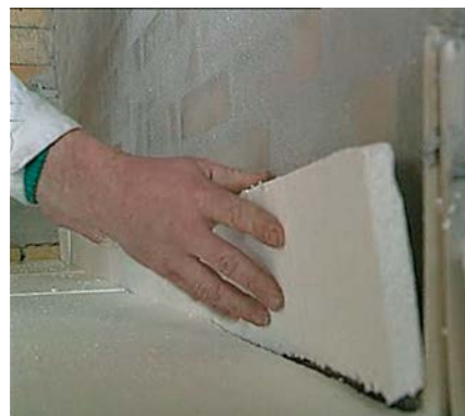
Montaż izolacji pionowej
